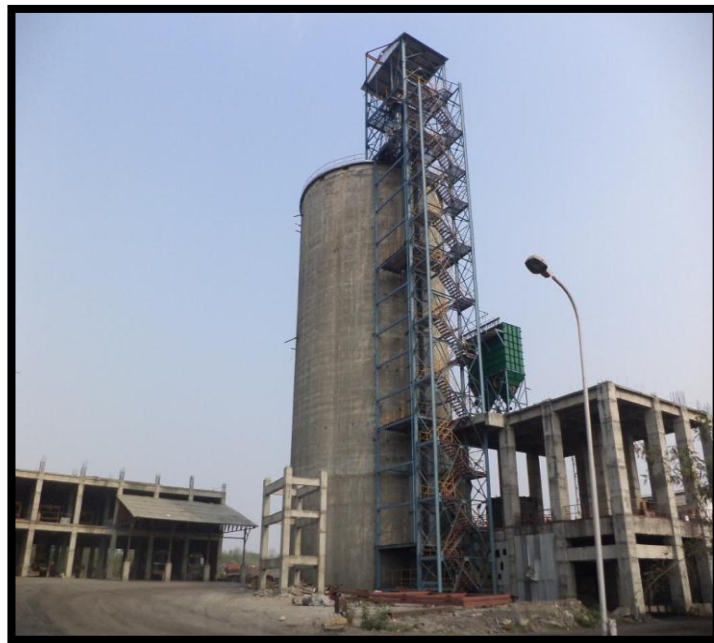
fly ash silo
